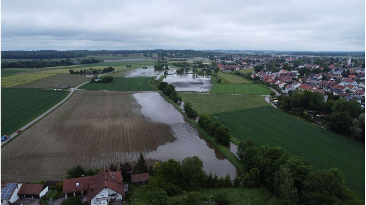
Überschwemmungen des Unteren Flutkanals im Bereich (Quelle: Martin Wecker)
