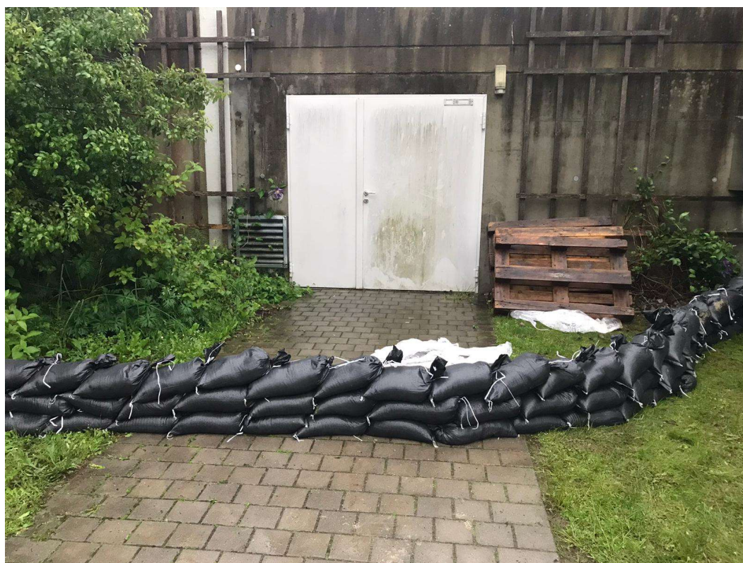
Bürgerhaus (Heizraum mit Pelletslager)
