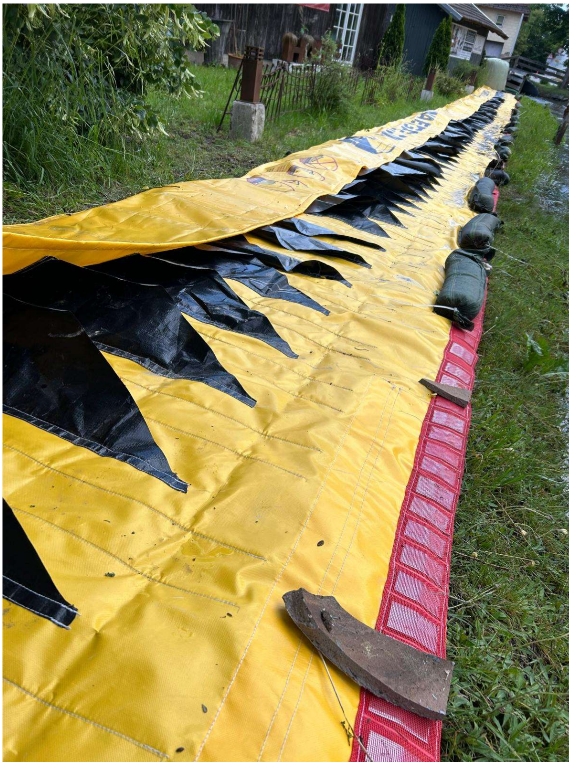
Mobiler Hochwasserschutz in der Gemeinde Alling
